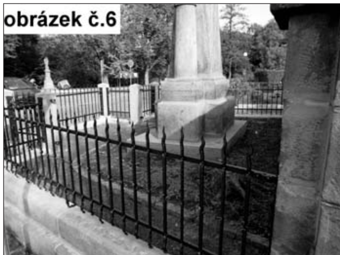
Záběr na delší pole kovového oplocení
