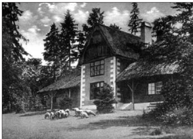
Obr. č. 1 – Slatiňany – Švýcárna, severní průčelí, zač. 20. století.
