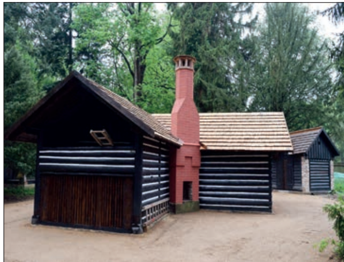
Opraveným roubenkám se navrátí původní funkce i barevnost.
