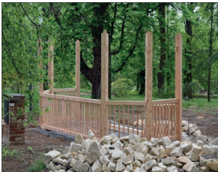
Altán u hřiště ve výstavbě.
